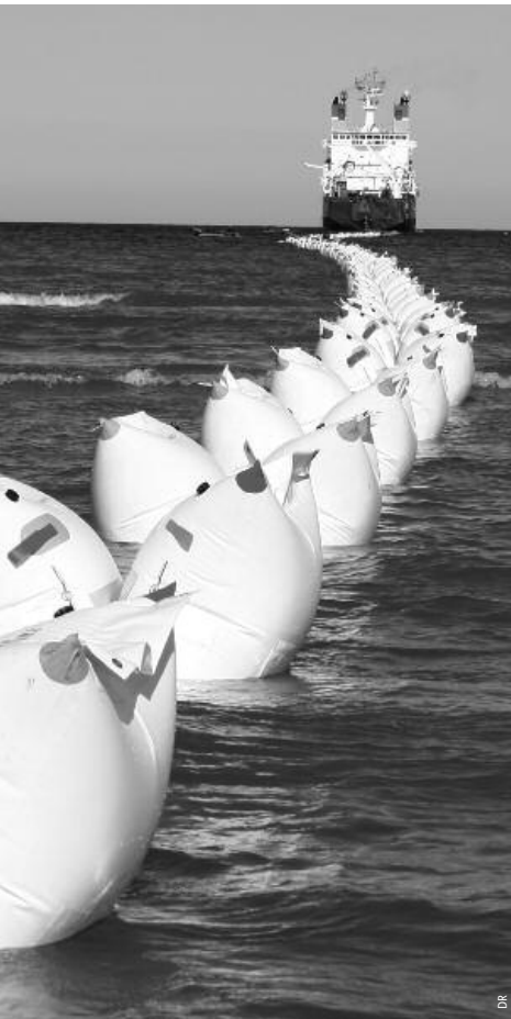
Opération de câblage sous-marin.
